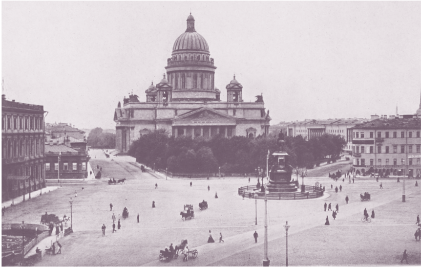
Рис. 1.10. Исаакиевский собор. Архитектор Огюст Монферран. 1818–1858 гг. Санкт-Петербург, Россия
