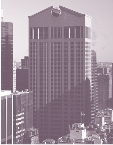
Рис. 1.31. Здание компании AT&T, позже — компании Sony. Архитектор Филип Джонсон. 1978–1984 гг. Нью-Йорк, США
