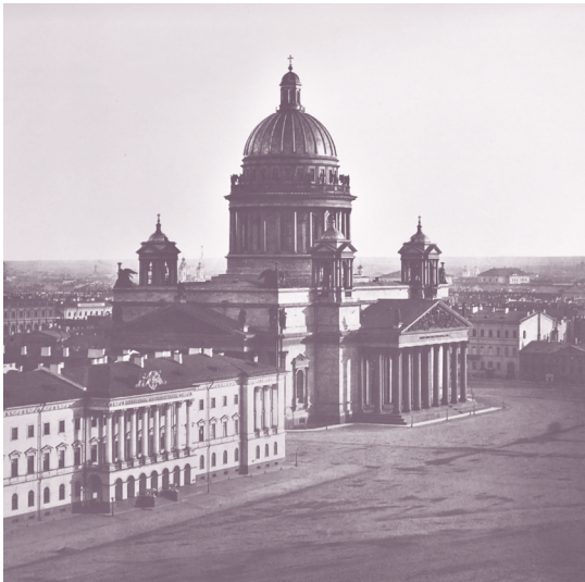
Рис. 1.11. Исаакиевский собор. Архитектор Огюст Монферран. 1818–1858 гг. Санкт-Петербург, Россия
