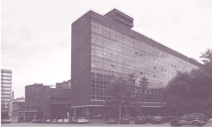
Рис. 1.27. Здание Центросоюза. Архитектор Ле Корбюзье при участии Пьера Жаннера и Николая Колли. 1928–1937 гг. Москва, Россия
